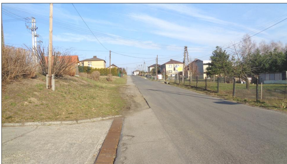
ULICA KRZYŻOWA - WIDOK W KIERUNKU PÓŁNOCNYM
