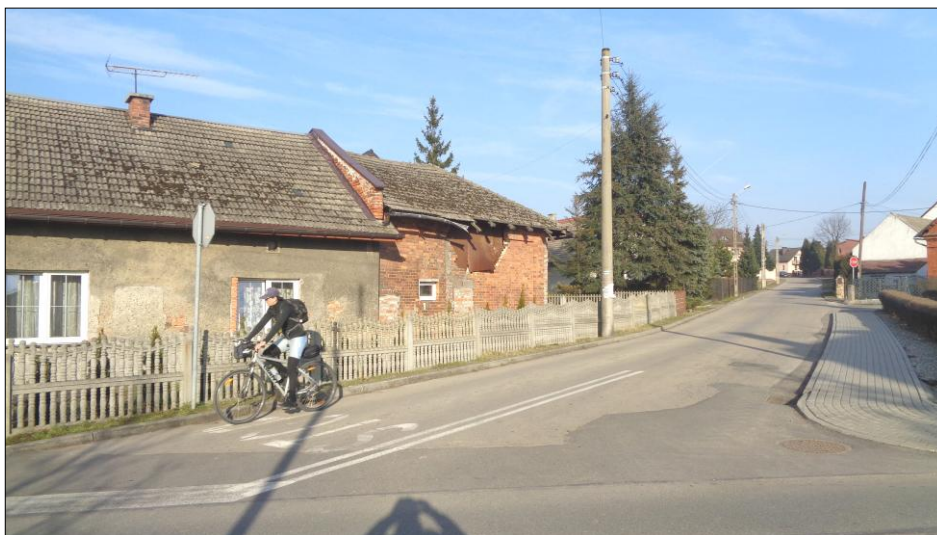
WIDOK NA ZABUDOWĘ PRZY ULICY POLNEJ
