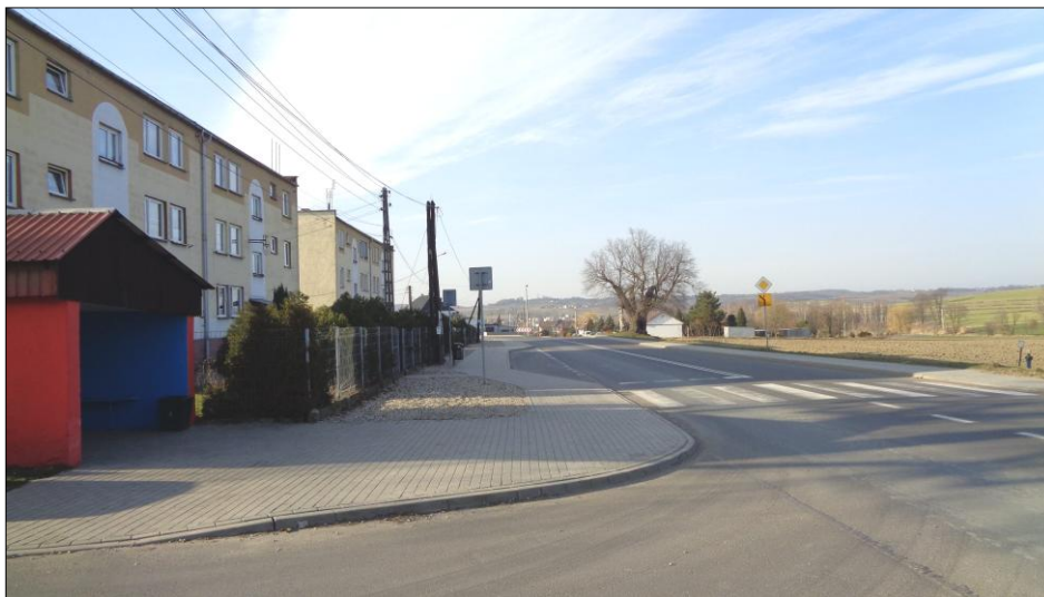
ZABUDOWA WIELORODZINNA PRZY SKRZYŻOWANIU ULIC A.ASNYKA I BORDYNOWSKIEJ
